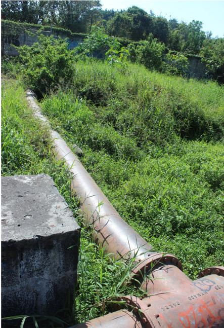
**Figure 6.** Photo des canalisations qui acheminent l'eau de la source et suivent le tracé de l'ancien canal Casasano (2014).
